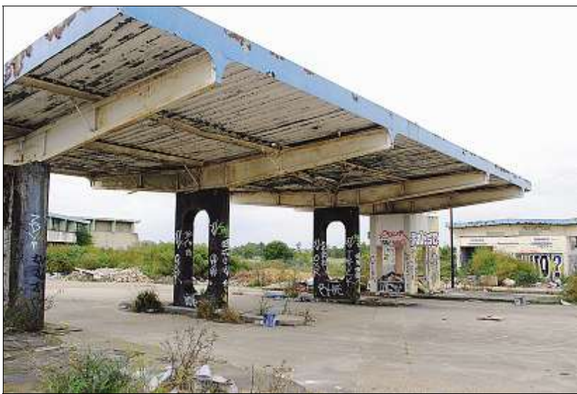
STATION-SERVICE. À l'image de celle qui est le long de la RN7 à côté du lycée du Chesnoy, la friche est la bête noire des élus de l'agglomération. Il en existe huit, soit 50 hectares sur les 550 dédiés aux zones d'activités.
